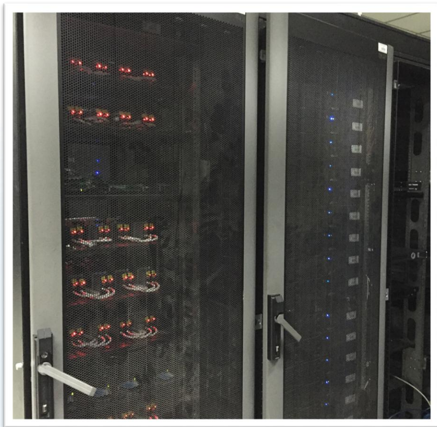
左侧为信号接入机柜，右侧为串流服务器机柜
